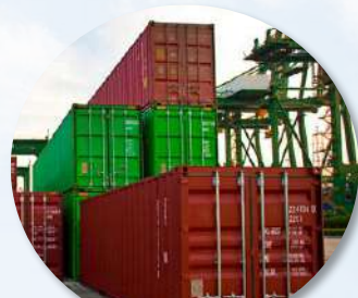
Infraestructura de servicios logísticos
