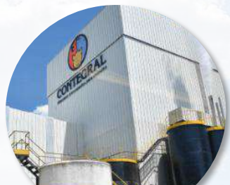
Infraestructura de servicios para la producción
