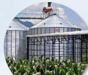
Infraestructura para el almacenamiento y alistamiento
